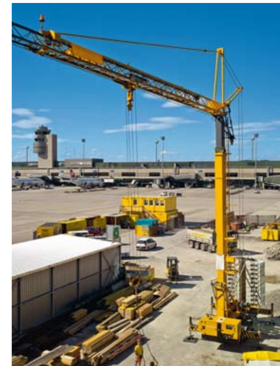
Маневренный: кран 32 TTR – максимальная адаптация благодаря телескопической башне и стреле
