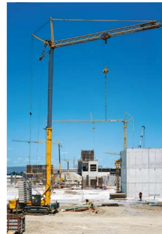
Быстрая смена местоположения: передвижение на крупных строительных площадках
